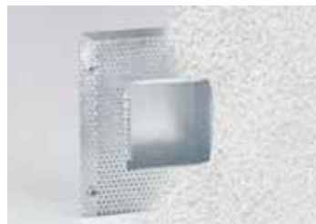
2. Spachtel, Putz oder Abrieb (min. 8 mm) aufbringen.
