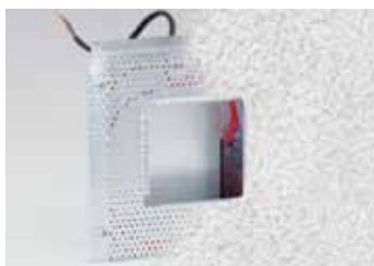
3. Transformator einsetzen und entsprechend verkabeln.
