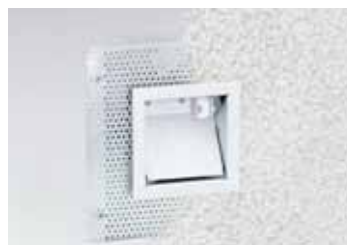
4. Blattfedern zusammenpressen und die Leuchte bündig einsetzen.
